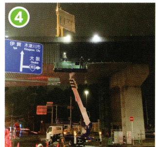
桁設置作業の様子 (令和元年5月撮影)
