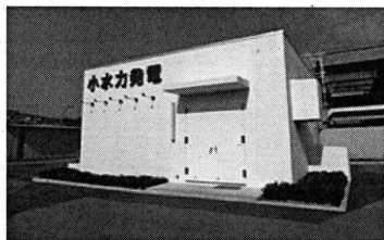
山崎浄水場 小水力発電 (生駒市保有)
