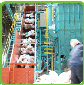
とうにゆう 投入ピット エプロンコンベヤ
