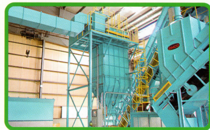
集塵機・脱臭装置
